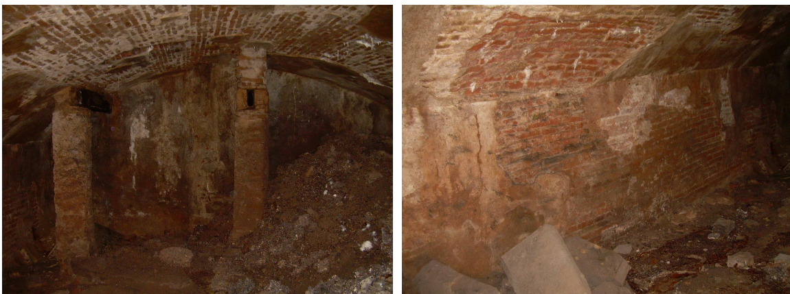
Vista del soterrani i detall de la paret de maó vist amb arrebossat de calç que limita amb la fonamentació corresponent amb les UE 109, 209 i 309.
